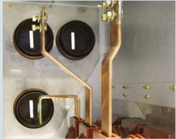
额定短路开断电流25kA，额定电流1250A母线室结构
